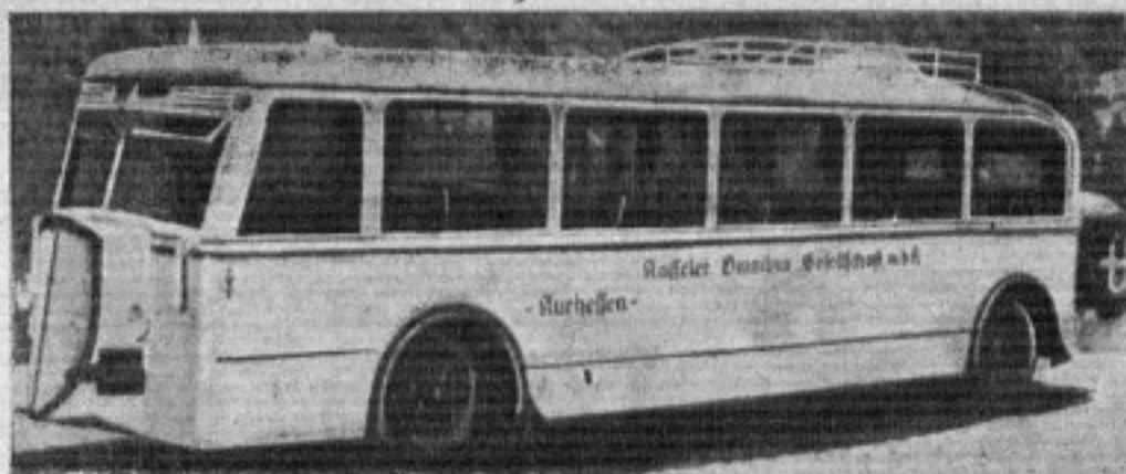
Автобус с газогенераторным двигателем Бюссинг и древесным газогенератором системы Имберт (в задней части кузова)
